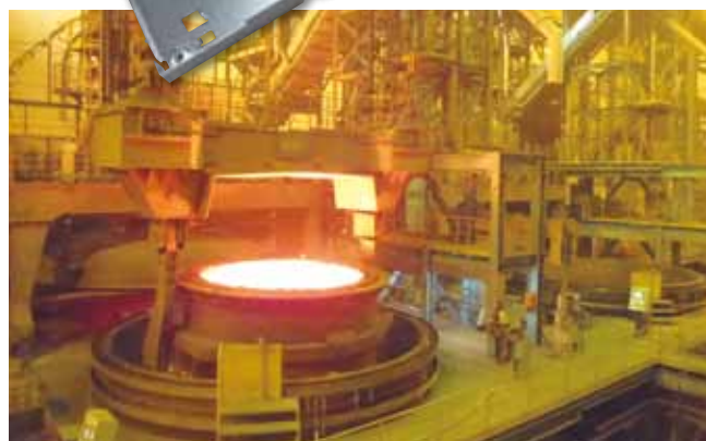
東京製鐵の電気炉
