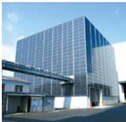
外装由太阳能面板构成的排水处理设施
