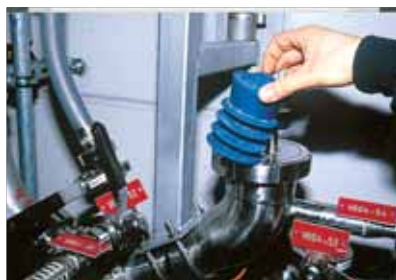
利用空压按下球体清洁器清洗管道
