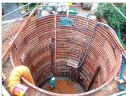
土壤挖掘除去工程(理光大森工厂)
