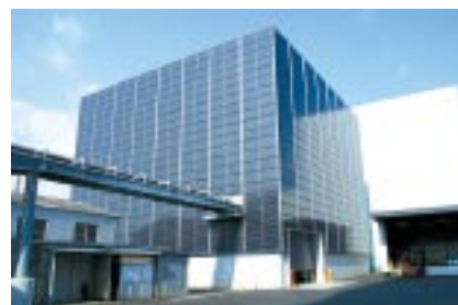
外装をソーラーパネルで構成した排水処理施設
