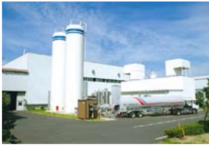
ローリー車により天然ガスを供給
