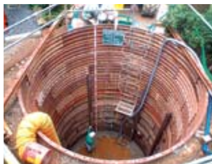
土壌掘削除去工事(リコー大森事業所)
