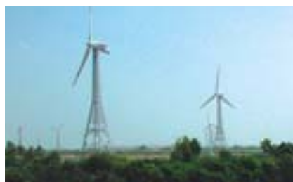
インドの風力発電施設
