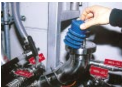
ボールクリーナーを空気圧で押し当て配管を洗浄
