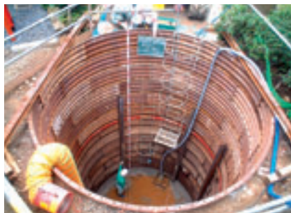
土壌掘削除去工事(リコー大森事業所)
