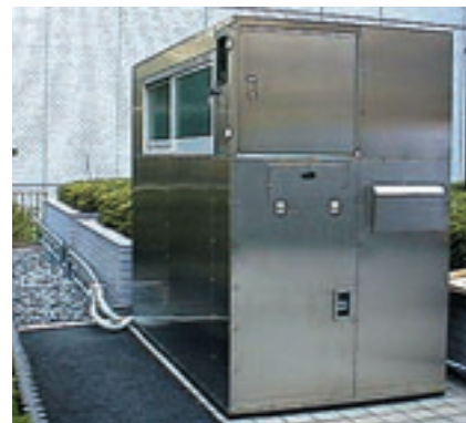
東北リコーが開発した揚水浄化装置
