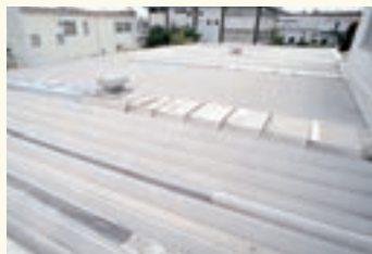
断熱塗装を施した工場の屋根
