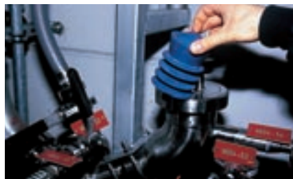
ボールクリーナーを空気で押しつけて配管を洗浄(リコーインダストリーフランス)
