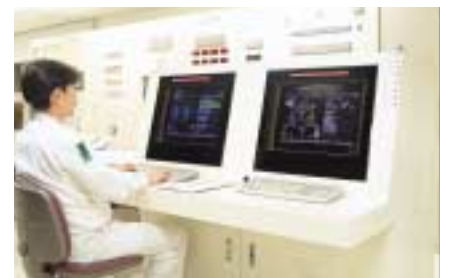
リコーやしる事業所の安全監視コントロールルーム。工場の各所に設けられた各種検出装置の状況をチェックしています。異常時には音と画面で警報を出し、コントロールルームより適切な指示を迅速に行います。
