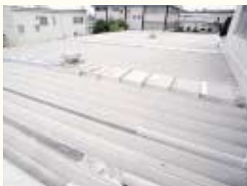
断熱塗装を施した工場の屋根
