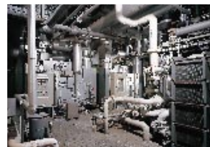
中央研究所のガス・コ・ジェネレーションシステム
