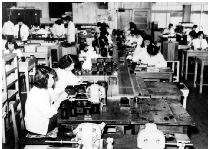
日本の産業界では初のベルトコンベアシステムを採用（1953年） これによるカメラの大量生産方式は後の大河内記念生産賞受賞にもつながりました
