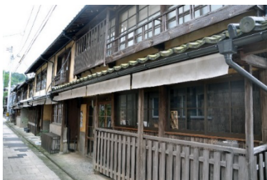
古民家を改修した町並み 【7月19日、大洲市】
