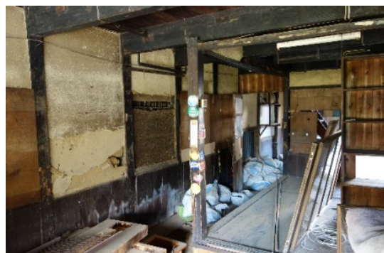
空き家だった改修前の古民家 【19年10月、大洲市=キタM提供】
