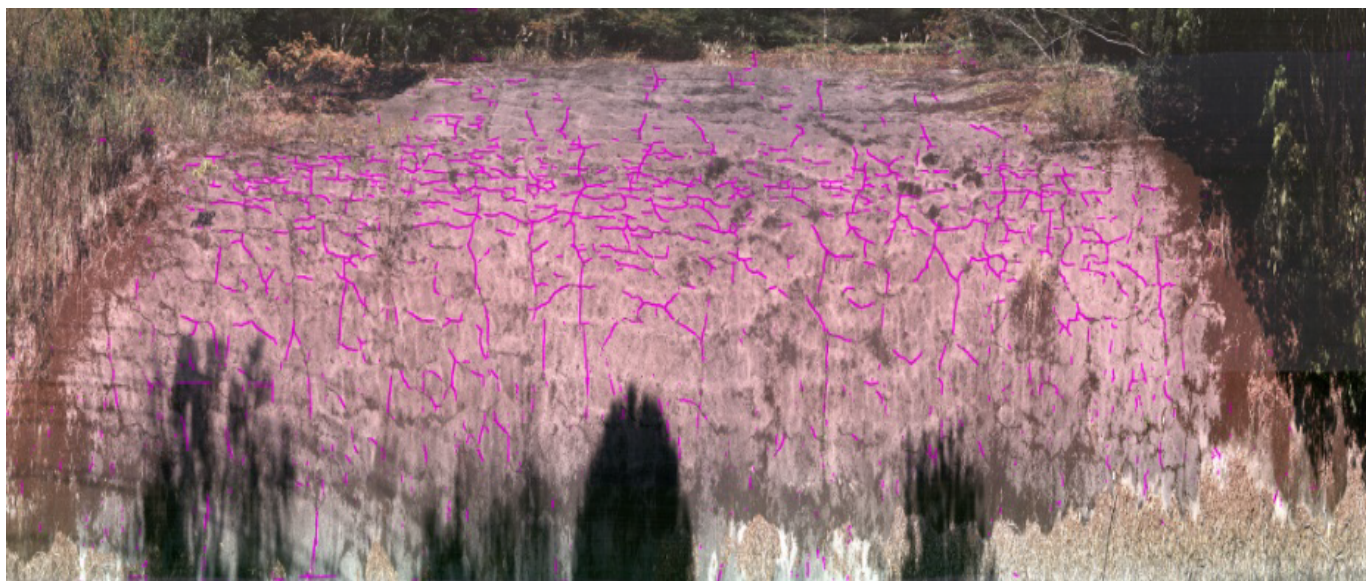
AIによるひび割れ判定を加えた「のり面」検査画像の例 (出所) リコー社会インフラ事業センター
