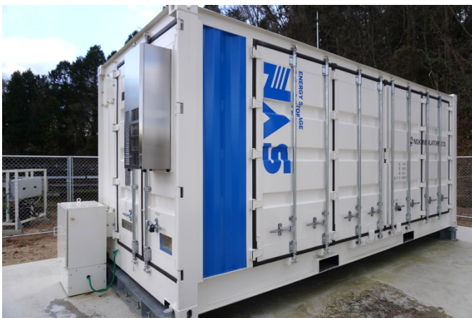
恵那電力の吉田発電所 太陽光発電設備 (上)、NAS 電池 (下) (写真) 筆者
