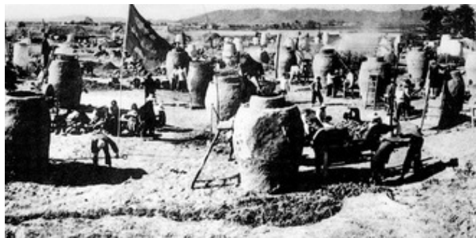
躍進運動期の手造り炉 (出所) Wikimedia Commons
