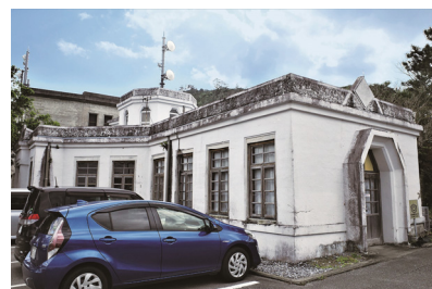
大宜味村役場・旧庁舎（1925＝大正14年竣工、国の重要文化財）
