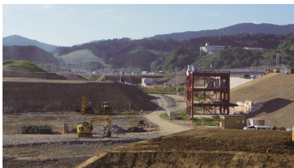
盛土と旧防災対策庁舎
