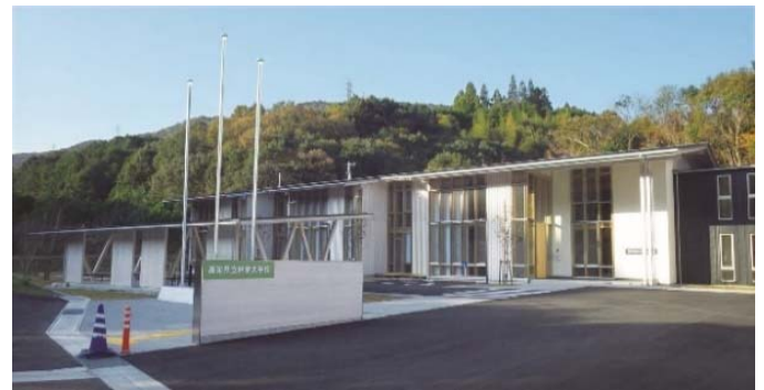
高知県立林業大学校の新築校舎（写真）筆者
