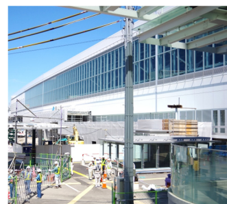
北陸新幹線工事中のJR富山駅
