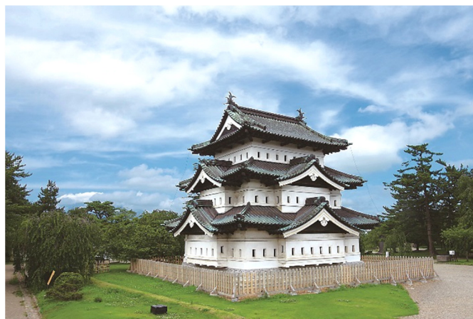
「曳屋」で移動した現在の天守
