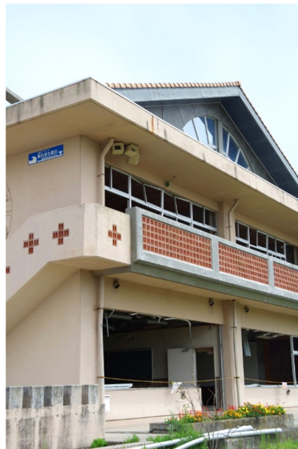
町立中浜小学校では「ブルー線」まで津波が押し寄せたが、児童全員が三角形の屋根裏部屋に無事避難
