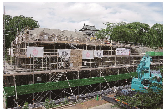
修復工事中的の本丸石垣
