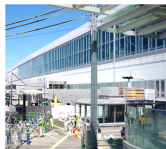
北陸新幹線工事中のJR富山駅
