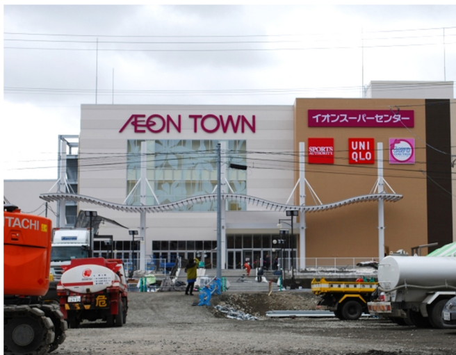
中心街にオープンした「イオンタウン釜石」（建設中に撮影）
