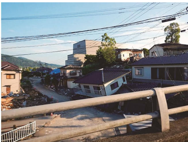
熊本地震の直後 (提供) 国立環境研究所
