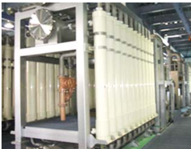
東京都水道局・砧浄水場（世田谷区）にある国内最大規模の膜ろ過施設（出所）東京都水道局ホームページ
