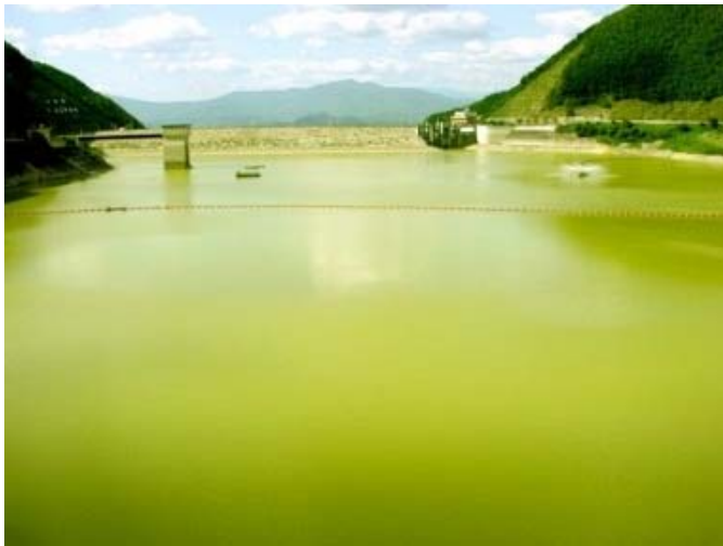
ダムの貯水池に発生したアオコ (提供) 独立行政法人・水資源機構
