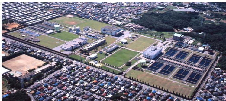
国内初の本格的な高度浄水施設を導入した千葉県・柏井浄水場 (提供) 千葉県水道局
