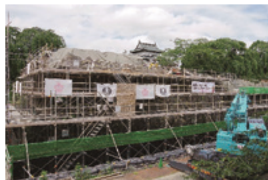
修復工事中的の本丸石垣
