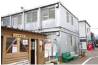
仮庁舎のままの山元町役場
