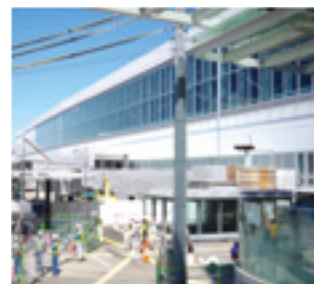
北陸新幹線工事中のJR富山駅
