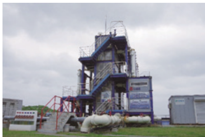
海洋温度差発電の実証設備
