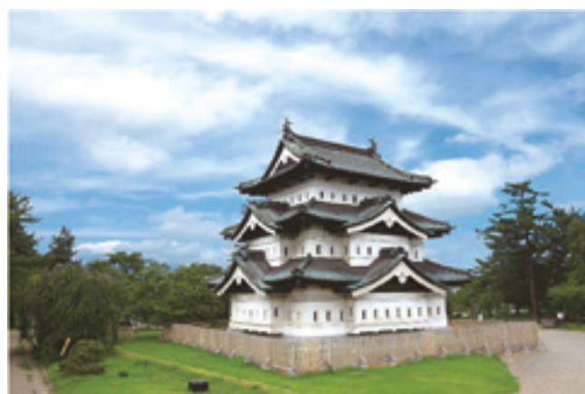
「曳屋」で移動した現在の天守
